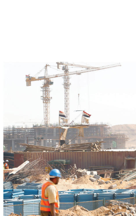
موقع بناء سد النهضة في مصر، حيث تجري أعمال البناء والتشييد.
